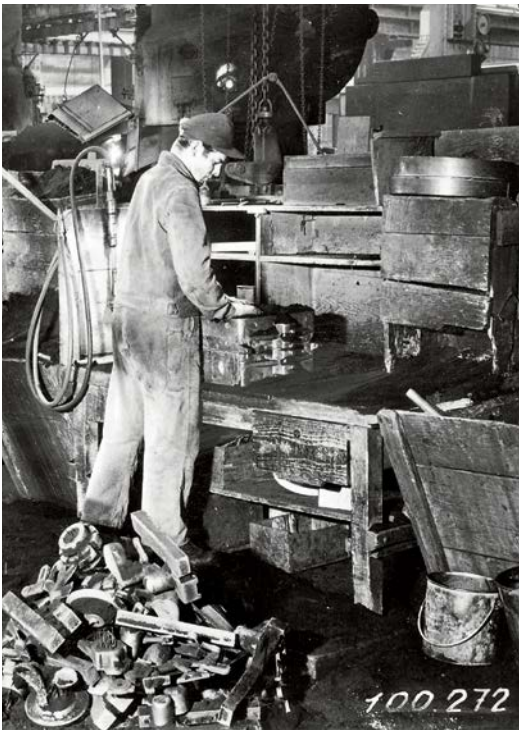
Si lavorava nella polvere e in molte fonderie il pavimento era interamente ricoperto di sabbia pressata.
