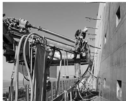
Bild 5: Es muss ein sicherer Zugang zur Bohrlafette gewährleistet sein.
