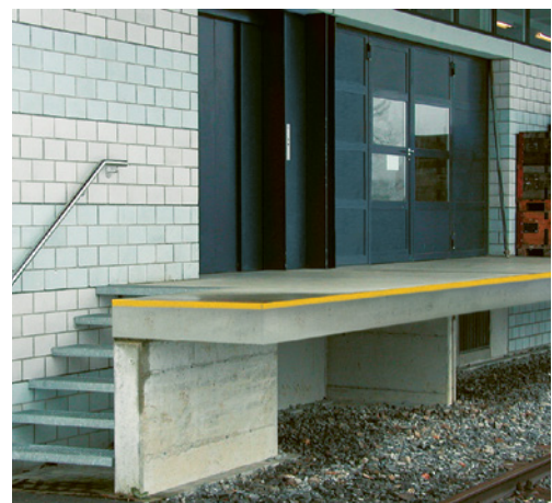
3 Freier Schutzraum unter der Laderampe.
