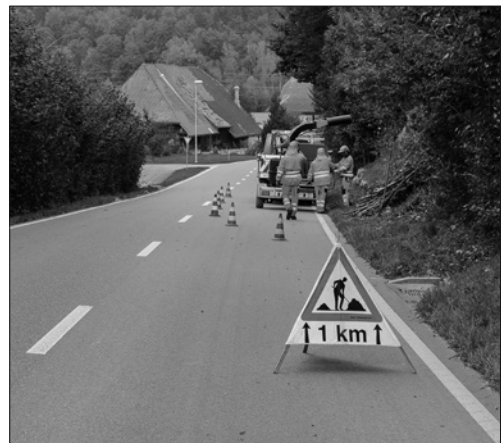
3 Signalisation de la zone de travail.
