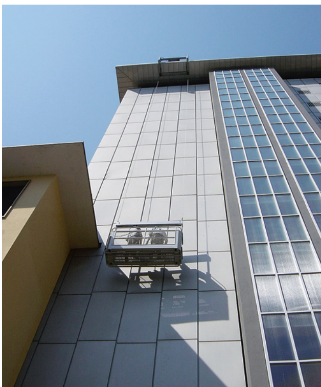
4 Nacelle de façade avec des potences guidées sous le débord de toit. Grâce aux potences adaptées aux conditions locales, les parties de façades difficilement accessibles peuvent également être atteintes.
