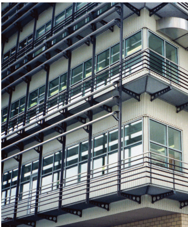
1 Balcons avec garde-corps. Ils permettent de nettoyer sans danger les fenêtres depuis l'extérieur.
