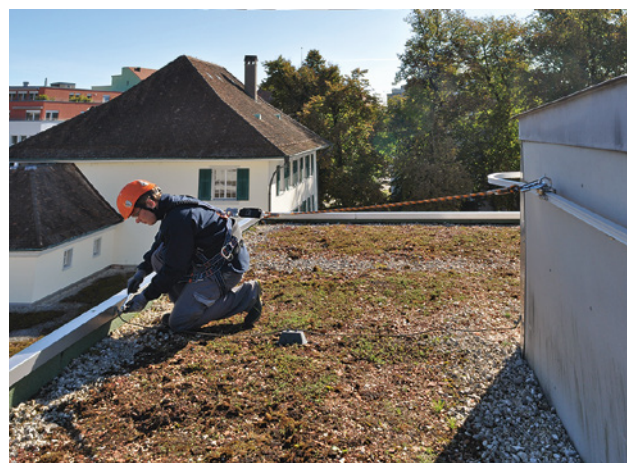
27 Les systèmes de retenue sont des équipements de protection individuelle (EPI) qui empêchent l'utilisateur de tomber du toit. Les systèmes de retenue doivent toujours être préférés aux systèmes d'arrêt des chutes.
