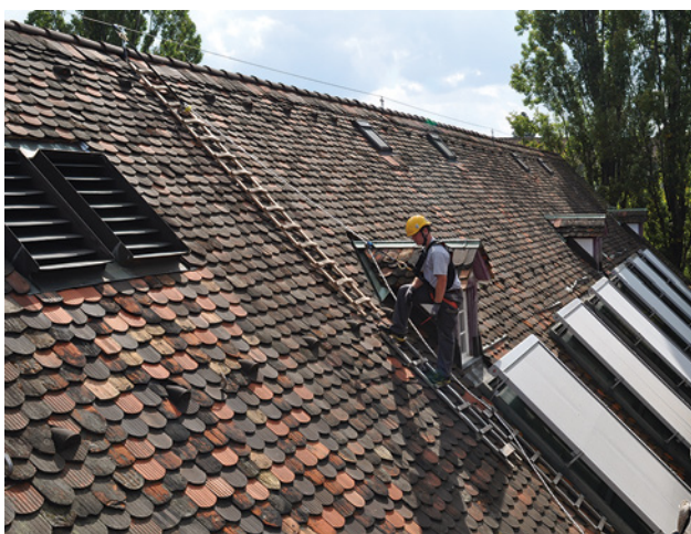
28 Les systèmes de maintien de la position au poste de travail sont des EPI. Ils permettent, en exerçant un appui ou une tension sur le système, d'adopter une position empêchant de trébucher dans la longe.
