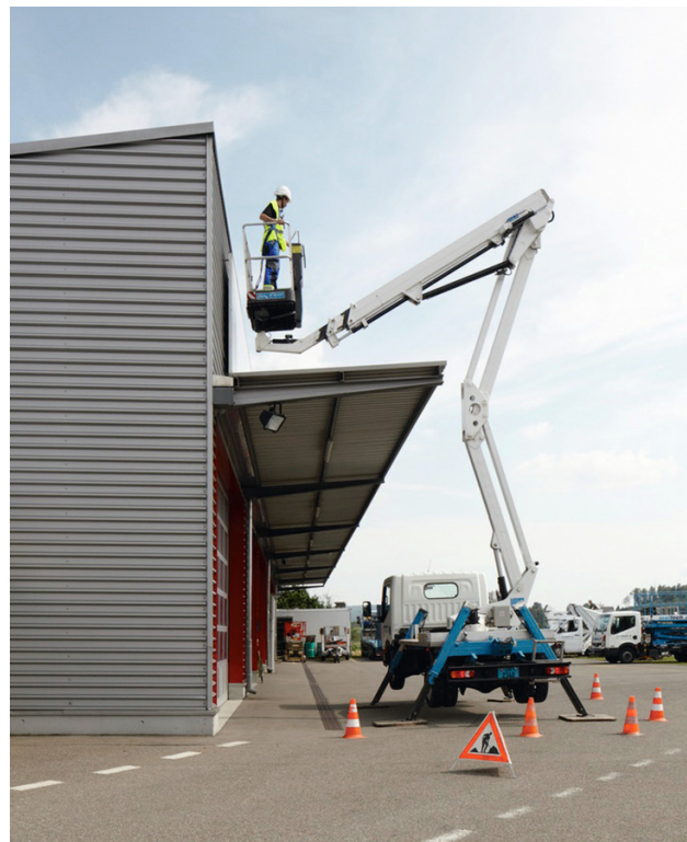
18 Travaux de nettoyage et de maintenance avec une plateforme élévatrice mobile de personnel.
