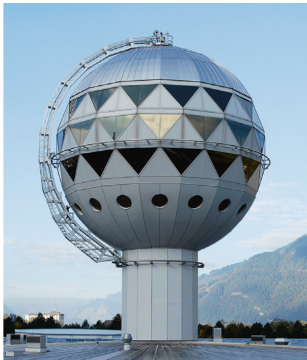
11 Dispositif d'accès aux façades équipé d'une plateforme fixe pour travaux de nettoyage et d'entretien sur un bâtiment spécial. Les personnes et le matériel sont protégés contre les risques de chute.
