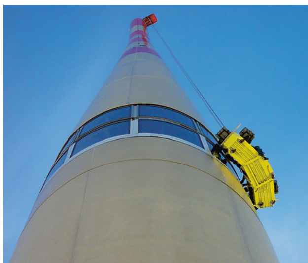
12 Pylône émetteur avec dispositif d'accès spécialement adapté aux ouvrages arrondis. Pour permettre l'utilisation du dispositif, les potences doivent être rabattues vers l'extérieur au sommet du pylône.
