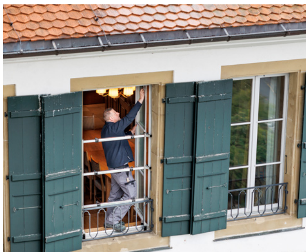
19 Le dispositif de sécurité pour châssis de fenêtres permet à la personne qui se trouve sur le rebord de la fenêtre de travailler en toute sécurité.
