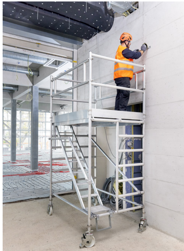
22 Travaux depuis un échafaudage roulant.
