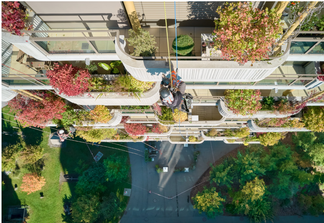
30 Travaux de nettoyage et d'entretien sur cordes. La personne qui travaille est assurée par deux cordes fixées séparément.
