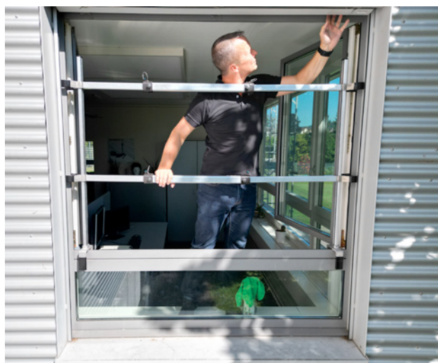
20 Le dispositif de sécurité modulable pour châssis de fenêtres se pose dans l'ouverture de la fenêtre depuis l'intérieur du bâtiment afin de travailler en toute sécurité.
