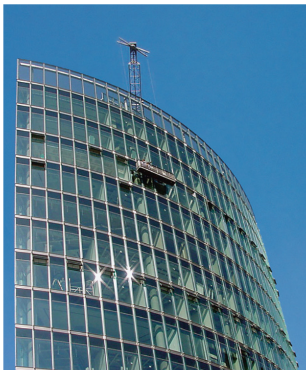
5 Toute la façade est accessible rapidement et en toute sécurité grâce à la nacelle ou à la plateforme de travail qui se déplace latéralement et verticalement.
