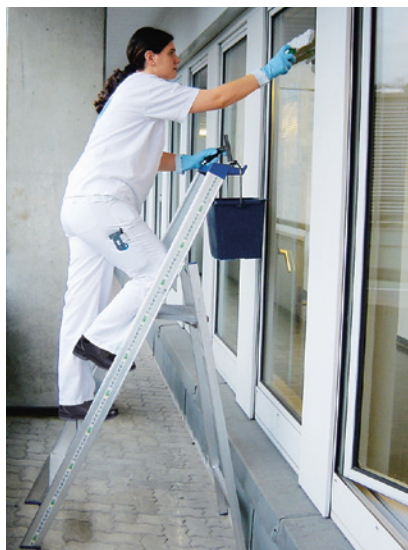
24 Comme le travail ne peut pas être exécuté au sol, on utilise un escabeau avec plateforme à 2 m du sol au maximum.
