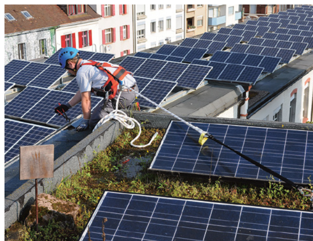
29 Les systèmes d'arrêt des chutes sont des EPI qui rattrapent l'utilisateur en cas de chute et limitent l'impact du choc.
