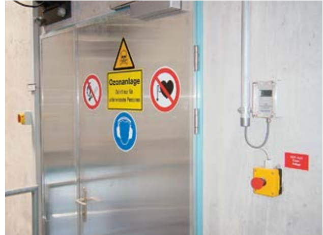
Fig. 2 Bouton d'arrêt d'urgence à l'extérieur du local d'implantation de l'ozoniseur
