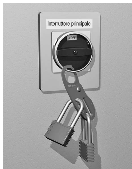
Fig. 6: interruttore generale lucchettabile
