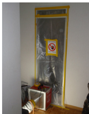
5 Zone d'assainissement confinée avec appareil de sous-pression
