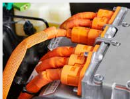
Câbles orange indiquant la présence de systèmes haute tension
