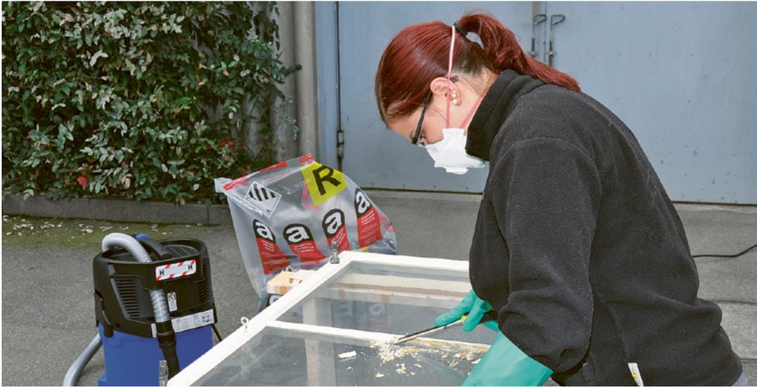
Enlèvement de mastic de fenêtres amianté à la spatule ou au ciseau à bois. **Ce travail doit être réalisé à l'air libre!**
