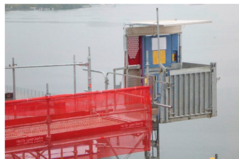
4 Accès sûr à la plateforme d'un ascenseur de chantier
