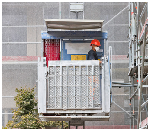
3 Plateforme avec toit de protection
