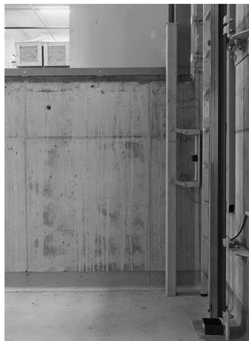
Fig. 3: dispositif mécanique à commande manuelle (béquille de blocage) placé ici dans la gaine d'un monte-charge avec une fosse
