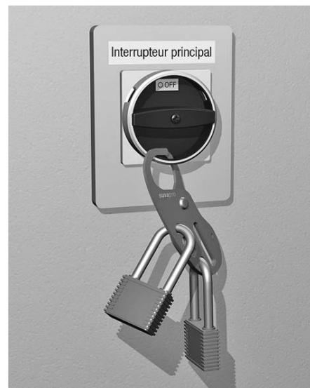
Fig. 6: interrupteur principal verrouillable
