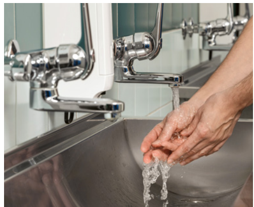
5 Auf der Baustelle braucht es genügend Waschgelegenheiten.
