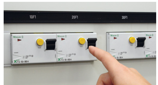
Bild 20: Fehlerstromschutzschaltungen sind in feuchten und nassen Räumen zwingend vorgeschrieben.
