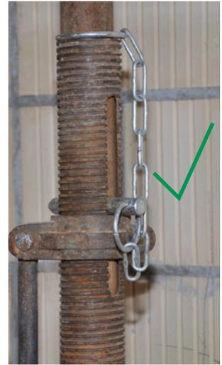
5 Geeigneter Steckbolzen, gegen Verlust gesichert
