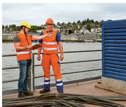
1 I lavori vicino, dentro o sopra l'acqua richiedono approfondite conoscenze tecniche e il coordinamento sistematico delle misure di sicurezza.
