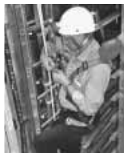
Figura 5: adeguati dispositivi anticaduta. – Scala con dispositivo anticaduta. – Se risulta impossibile eliminare i guasti dalla scala, usare un apparecchio anticaduta sulla schiena. – Casco con lampada frontale.
