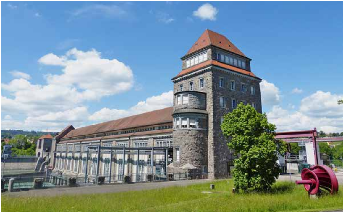
Das Rheinkraftwerk Laufenburg verläuft über die Grenze zwischen Deutschland und der Schweiz.
