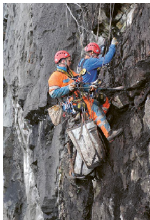
1 Le attività di messa in sicurezza della roccia richiedono una meticolosa preparazione del lavoro e formazione del personale.
