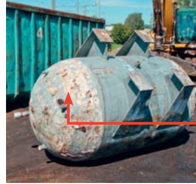
Asbesthaltige Isolation an einem Wassertank
