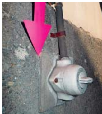
Asbestzementplatten bei Schaltern und Verteilern
