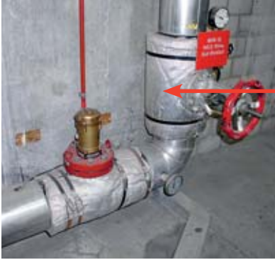
Asbesthaltige Isolationsschalen
