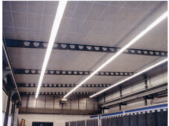
15 Beschichtete Steinwolle-Akustikplatten in einer Spenglerei.
