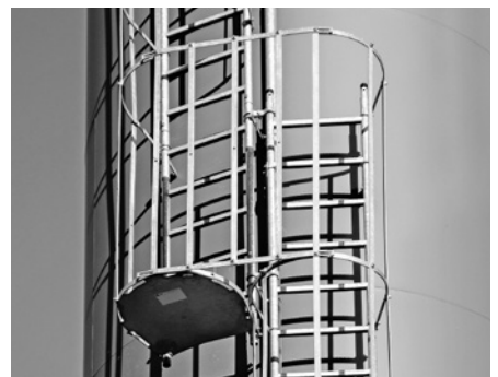
10 Plateforme intermédiaire entre deux volées consécutives d'une volée d'échelle. Le palier de l'échelle supérieure doit avoir une largeur minimale de 70 cm et recouvrir toute la circonférence de la crinoline.
