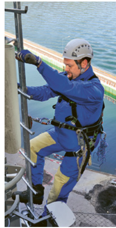
1 Échelle fixe à un seul montant avec antichute mobile. L'opérateur doit toujours avoir les mains libres.
