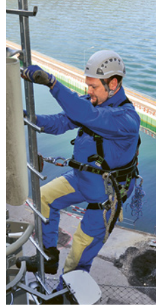
1 Échelle fixe à un seul montant avec antichute mobile. L'opérateur doit toujours avoir les mains libres.
