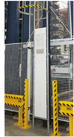
2 Échelle à crinoline avec dispositif anti-escalade (anti-intrusion) verrouillable.
