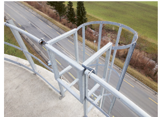
5 Le point de sortie de l'échelle est protégé par un portillon à fermeture automatique.
