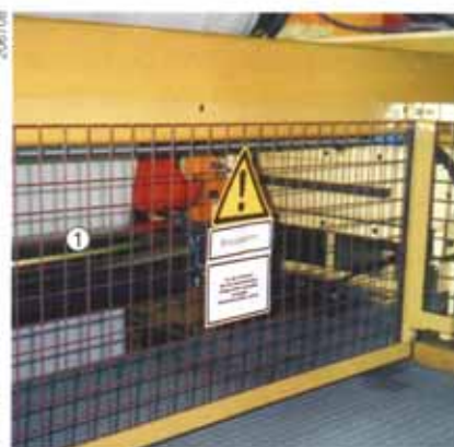
Figura 23: stazione bobine d'alimentazione in un'azienda della lavorazione di materiale sintetico. Schermatura della zona d'imbocco e di schiacciamento (1) davanti ai cilindri d'estrazione.
