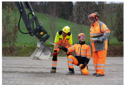
4 Ausbildung und Instruktion an der Baumaschine
