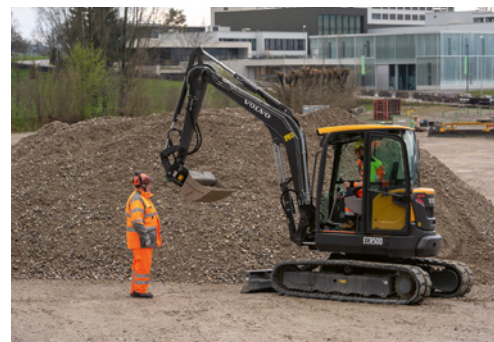
7 Person ist im Gefährdungsbereich der Baumaschine und hält Blickkontakt mit dem Maschinenführer
