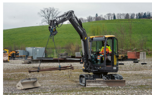
6 Last ist korrekt am Bagger für den Transport angeschlagen
