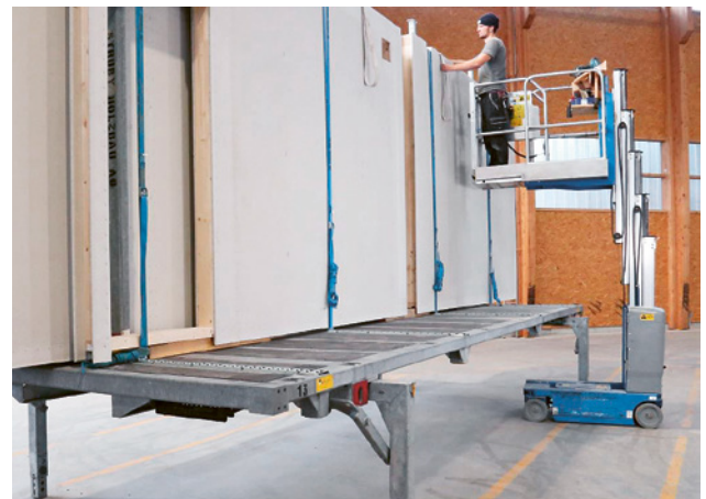
1 Sicherung der Holzelemente mit Zurrmittel.
