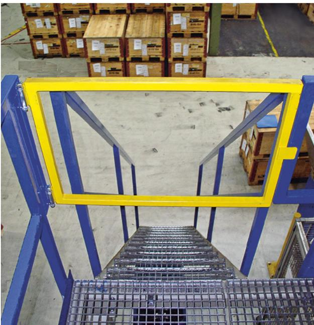
24 Portillon à fermeture automatique ne s'ouvrant que du côté de la plateforme de travail. Il est équipé d'une main courante et d'une lisse intermédiaire (positionnée au même niveau que la lisse du garde-corps) et se ferme contre une butée fixe.
