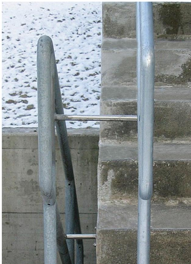
**15** Garde-corps avec un espace suffisant entre la main courante et l'escalier. L'extrémité de la main courante est conçue de sorte à éviter tout risque de blessure causée par des arêtes vives ou par la prise des vêtements de l'utilisateur.
