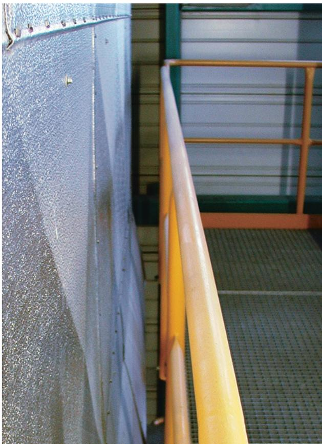
**7** Garde-corps servant à sécuriser des bords donnant sur le vide à proximité de murs ou de machines. L'installation d'un garde-corps est obligatoire, car la distance entre la passerelle et l'entourage de la machine dépasse 180mm.
