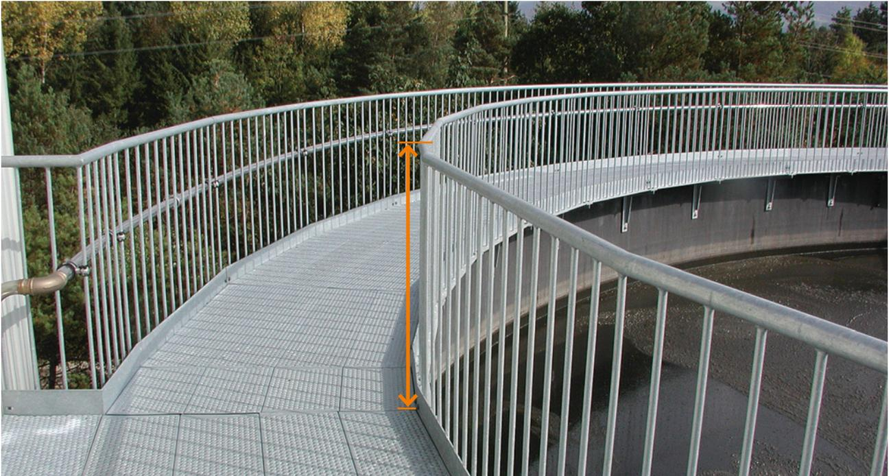
10 La hauteur du garde-corps, du niveau de circulation au bord supérieur de la main courante, est de 1,10m.
