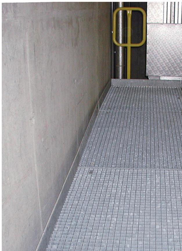
**8** Plinthe servant à sécuriser des bords donnant sur le vide à proximité de murs ou de machines. L'installation d'une plinthe est obligatoire, car la distance entre la passerelle et l'entourage de la machine dépasse 20mm. A l'arrière, où la distance est supérieure à 180mm, un garde-corps a été installé.
