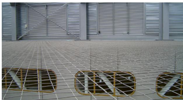
7 Variante: cavi di acciaio inossidabile per l'utilizzo permanente → nessuna rete di sicurezza!
