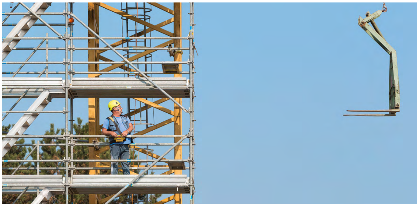
Marco Saligari kann trotz Beinprothese wieder als Kranführer arbeiten.
