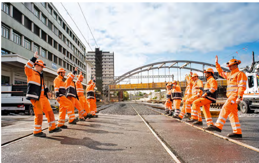
Baustelle Bern Wylerfeld: Mitarbeitende trainieren mit dem Footbag ihr Gleichgewicht. // Raffael Waldner
