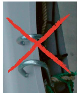
3 Les mouquetons ouverts perdent une grande partie de leur capacité de charge. En principe, ne jamais utiliser de mouquetons pour le montage des filets!
