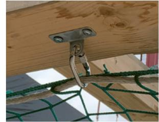
5 Suspension avec point de fixation contrôlé et mousquetons.
