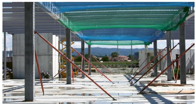
1 Les filets de sécurité permettent d'éviter les chutes à l'intérieur de l'ouvrage.
