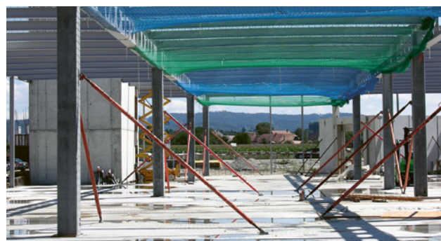
1 Les filets de sécurité permettent d'éviter les chutes à l'intérieur de l'ouvrage.
