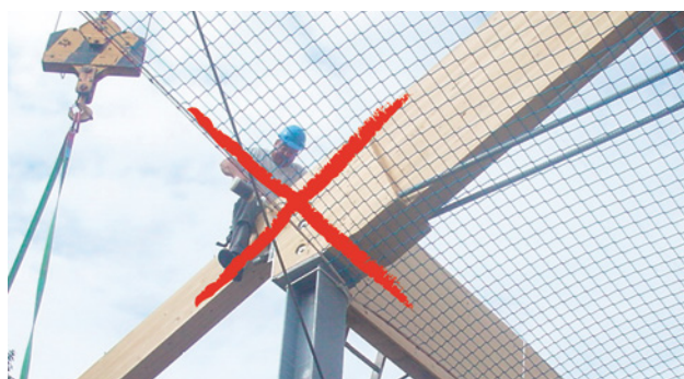
6 Dépassement insuffisant par-dessus le bord de chute: filet inefficace.
