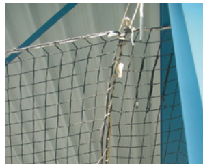
4 Raccord conforme
