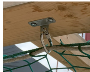
5 Suspension avec point de fixation contrôlé et mousquetons.
