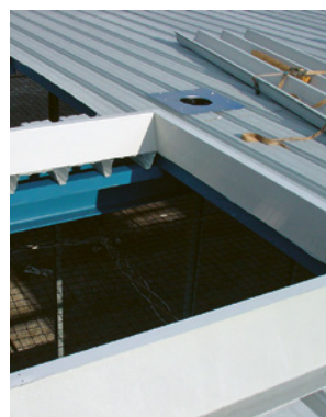
2 Filet placé directement sous les ouvertures d'un toit.
