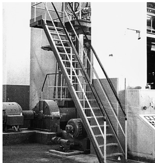
4 Escalier raide équipé d'un garde-corps de chaque côté.
