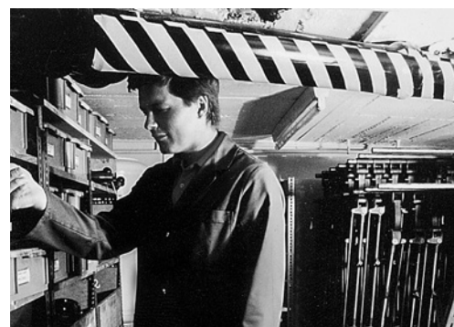
5 Tuyauterie à côté d'une étagère, rembourrée et signalée avec du caoutchouc mousse zébré jaune-noir.
