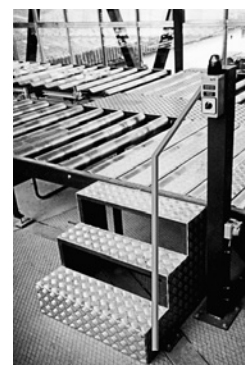
7 Passage au-dessus d'un convoyeur à rouleaux.
