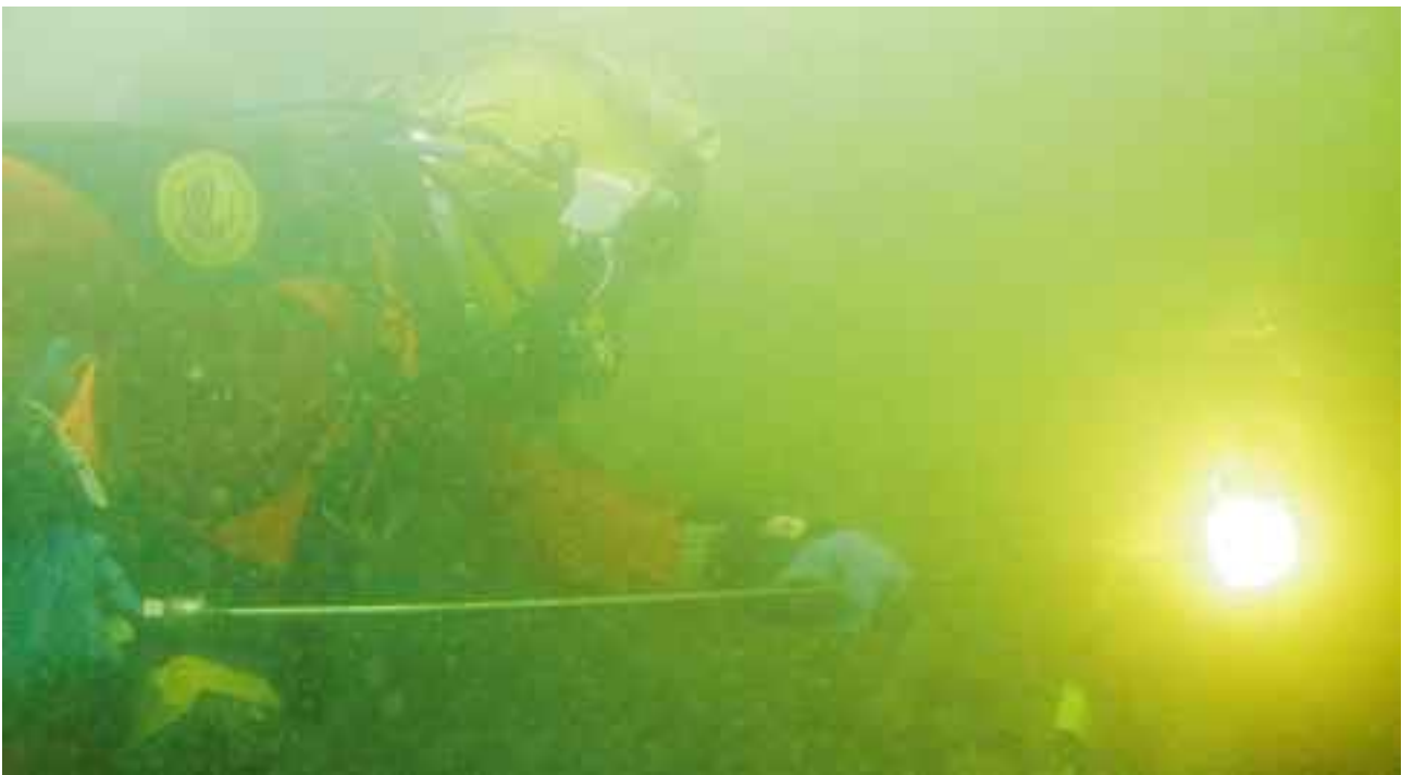
Unterwasserschweissen Foto: F. Hattan, Hergiswil
