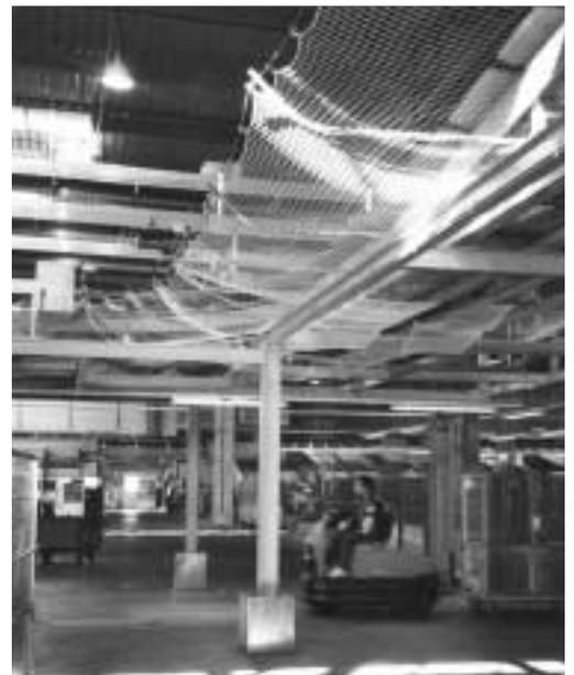
Figure 8: filets de protection installés au-dessus des voies de circulation.
