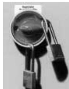
Figure 9: lors des travaux de maintenance, chaque monteur doit disposer de son propre cadenas pour pouvoir verrouiller l'interrupteur de sécurité de l'installation sur laquelle il intervient.
