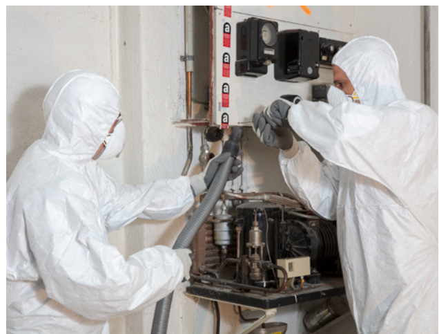
1 Lors de travaux exécutés sur des Eap contenant de l'amiante, les fibres libérées peuvent être captées avec un aspirateur de classe H.
