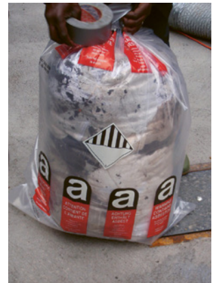
4 Kunststoffsack mit der Kennzeichnung Asbest
