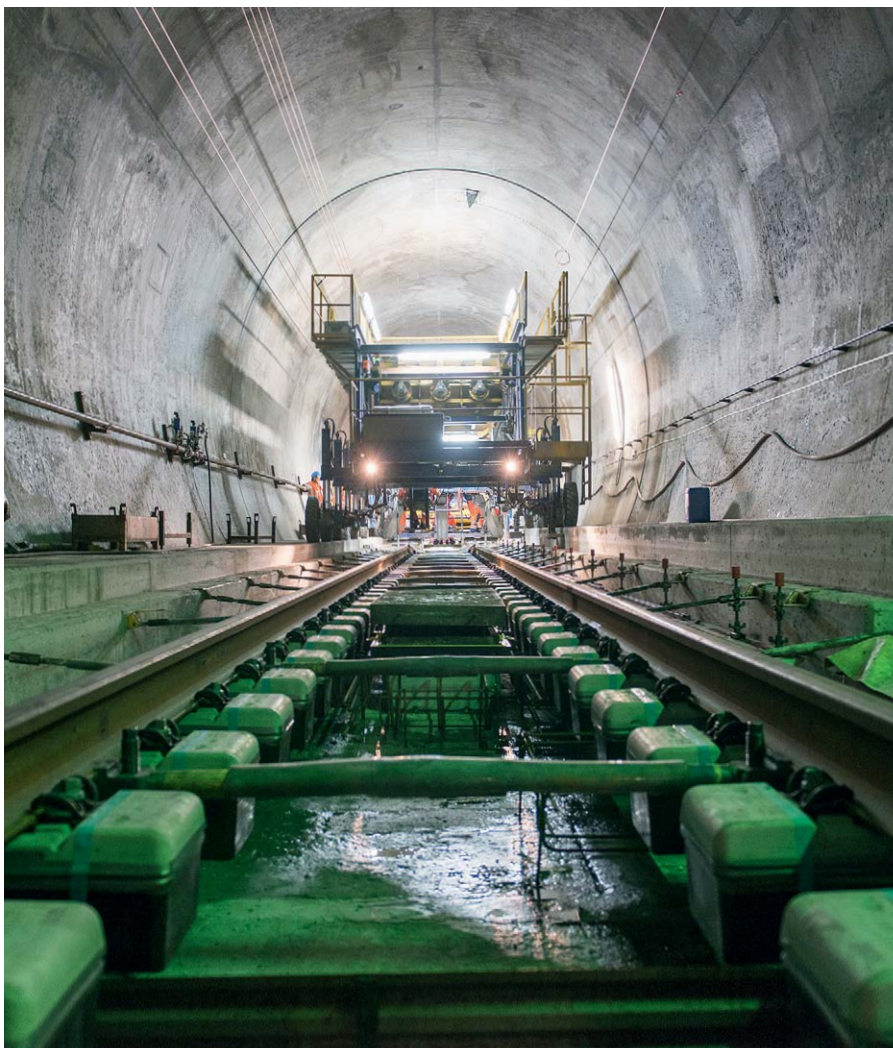
Un'impresa fuori del comune: lo scavo della galleria di base del San Gottardo // Keystone
