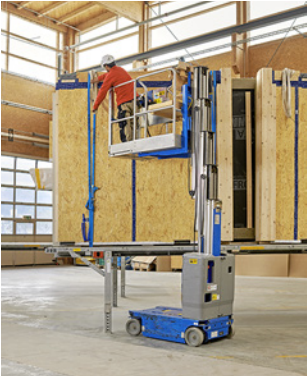
Regola 7 Mettere in sicurezza gli elementi prefabbricati
