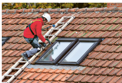
2 Le scale da copritetto impediscono di non scivolare in basso.
