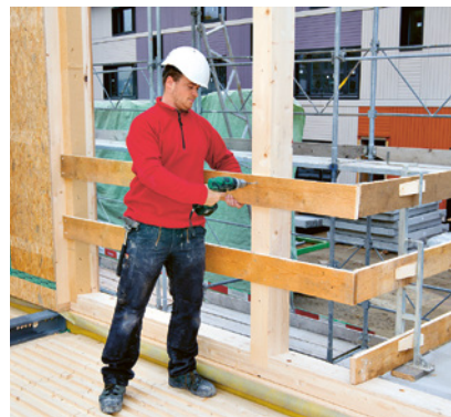
3 Apertura nella parete messa in sicurezza con una protezione laterale
