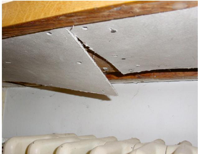
3 Asbesthaltige Leichtbauplatten als Brandschutzverkleidungen, z. B. bei Radiatoren
