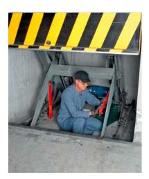
Travailleur: Je dis STOP lorsque je détecte des énergies résiduelles (par ex. une charge en hauteur non sécurisée). J'interviens sur une installation en marche uniquement si elle est pourvue d'un dispositif de marche particulière (par ex. commande de validation) garantissant ma sécurité.
