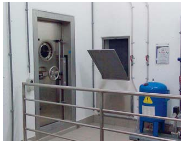
6 Räume mit erhöhten Radonkonzentrationen werden luftdicht verschlossen.
