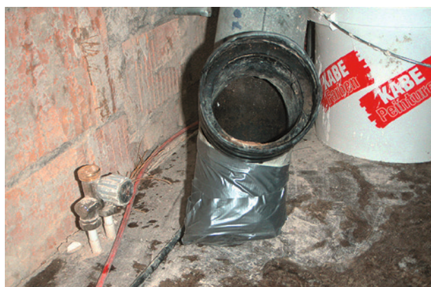
4 La zone de fracture est emballée hermétiquement.
