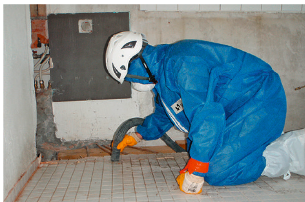
3 La zone d'assainissement est soigneusement nettoyée après le travail.
