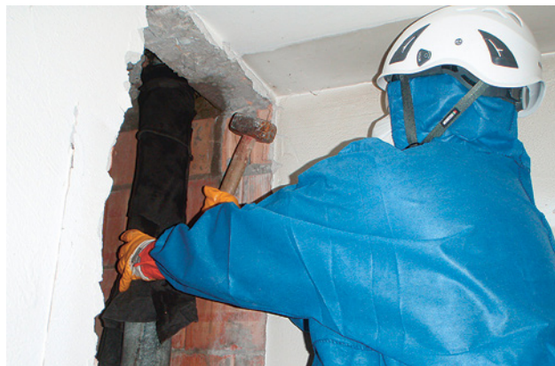
1 Démontage d'une conduite en fibrociment par fracture contrôlée.
