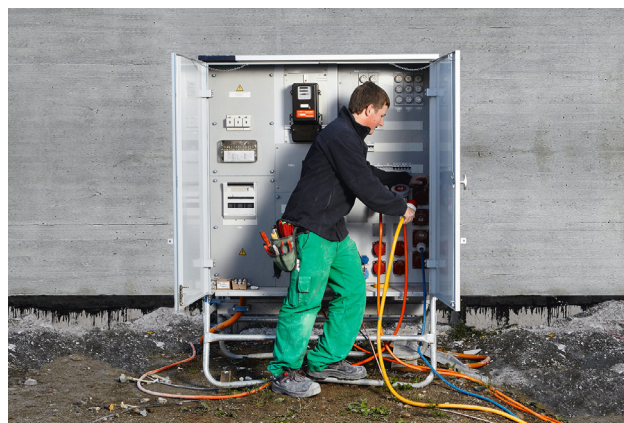
1 Monteur électricien installant un raccordement provisoire.
