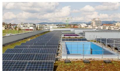
3 Apertura del tetto messa in sicurezza con un parapetto
