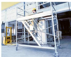
2 Accesso interno del ponteggio mobile su ruote
