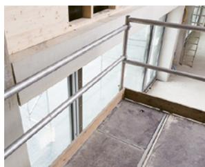
3 Protezione laterale sul ponteggio mobile su ruote
