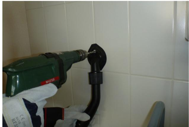
4 Bohrmaschine mit Quellenabsaugung im Einsatz an Keramikplatten mit asbesthaltigem Kleber
