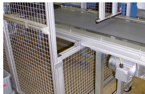
7 Die Öffnung unter dem Austragförderband ist mit einem Gitterelement geschlossen.
