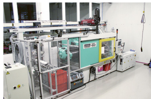
5 Grossräumige Umzäunung an einer Fertigungsinsel mit elektrisch überwachter Zutrittsstüre
