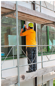
2 Échafaudage de façade utilisé comme protection contre les chutes
