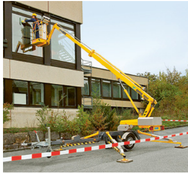
3 Plateforme élévatrice pour les façades difficiles d'accès
