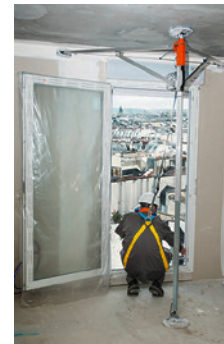
5 Harnais et système mobile antichute
