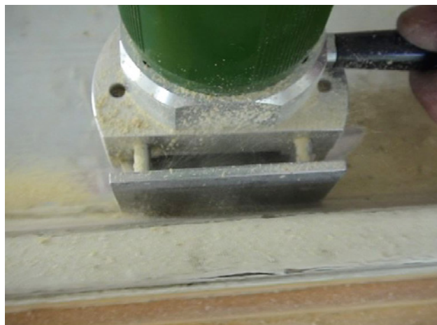
1 Entfernen von Fensterkitt mit einer Fugensäge
