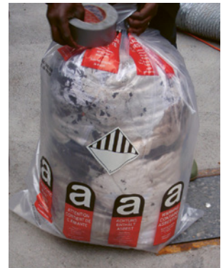
6 Kunststoffsack mit der Kennzeichnung Asbest
