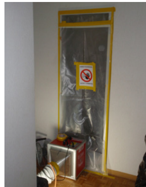
5 Abgetrennte Sanierungszone mit Unterdruckgerät
