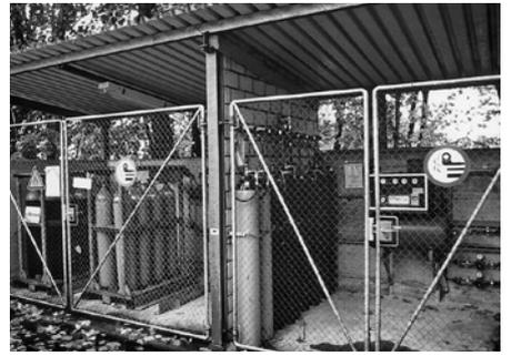
7 Mesures de protection contre les explosions sur une rampe de raccordement en plein air pour bouteilles de gaz ou cadres de bouteilles avec gaz inflammables (bonne aération naturelle, zone-ex 1).
