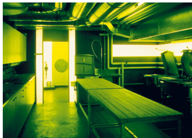
Figura 27 Illuminazione del locale mediante colori fotoluminescenti
