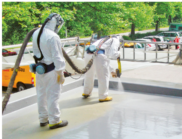
12 La pulvérisation de polyuréthanes nécessite des mesures de protection strictes, aussi pour les collègues travaillant à proximité.
