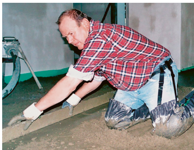
15 Les pantalons «de carreleur» à genoux imperméables permettent d'éviter les brûlures chimiques dues au ciment.
