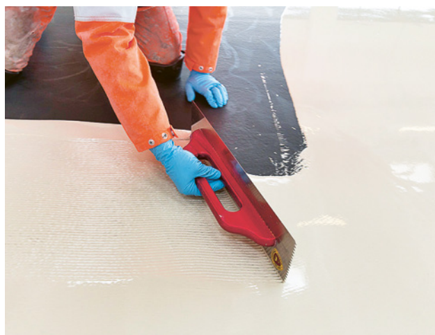
7 Les gants jetables n'offrent qu'une protection limitée et ne sont admis que si l'on en change après chaque contact avec des résines synthétiques.
