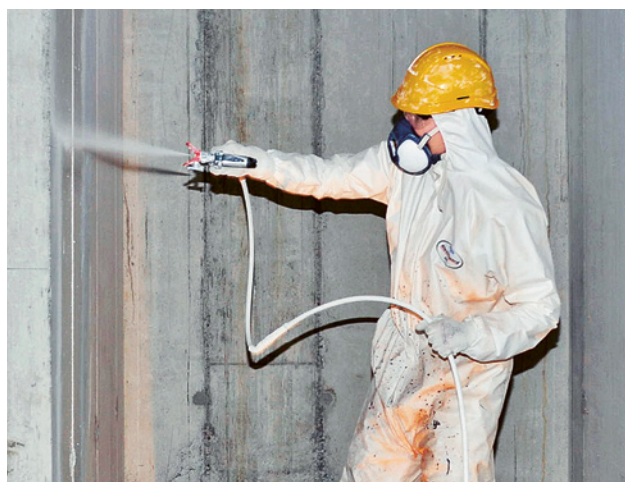
19 Lors de la pulvérisation de produits contenant des solvants, il faut toujours prendre des mesures pour prévenir les explosions. Le port d'un masque ou d'un système de protection respiratoire doit être systématique.
